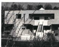
Qui sopra, il fronte principale della palazzina, di cui si nota, a centro pagina, un particolare: da sottointendere il gioco geometrico dei materiali a vista. Nell'altra pagina, in alto, una vista d'insieme dell'entrata con i giardini e la cornice di calcestruzzo di argilla espansa posti a 45 gradi. Le foto del servizio sono di Vito Randelli.
